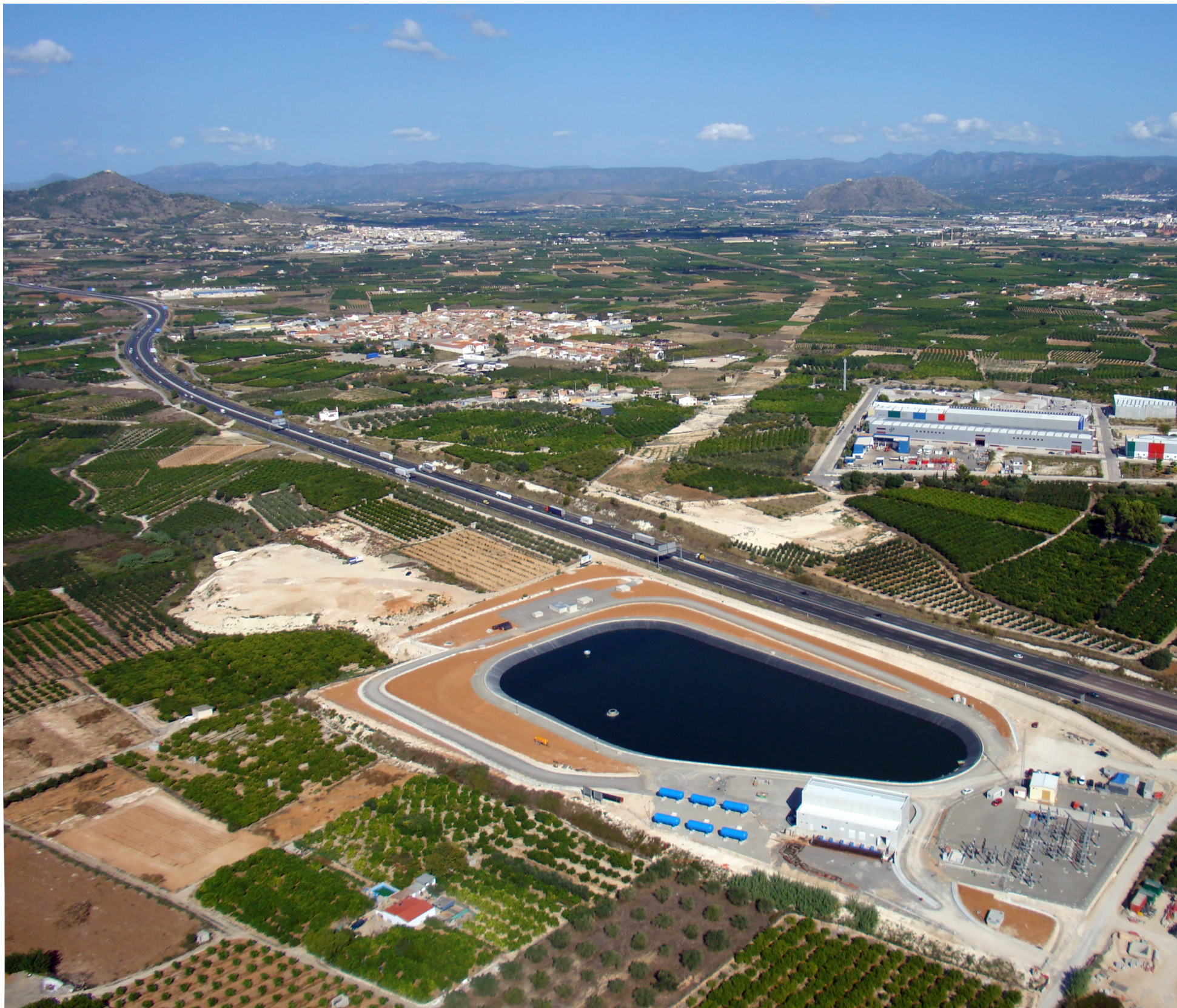
Foto: Balsa y estación de bombeo de la conducción Júcar-Vinalopó en Llanera de Ranos
